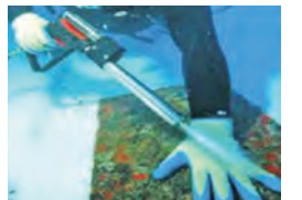
水中浚渫工法導入で管内に水がある状態での堆積物回収を実現
